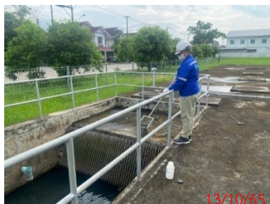
จุดเก็บตัวอย่างน้ำจากบ่อพักน้ำก่อนเข้าสู่ระบบบำบัดน้ำเสีย
